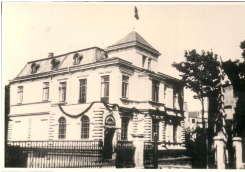
Altes Gewerkschaftshaus in der Schulstraße
